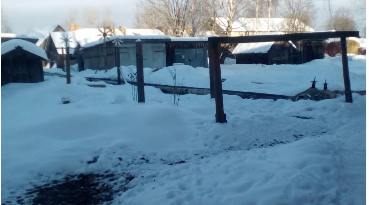
Рис. 3.25. Участок №9 тепловой сети котельной ул. Десантная
