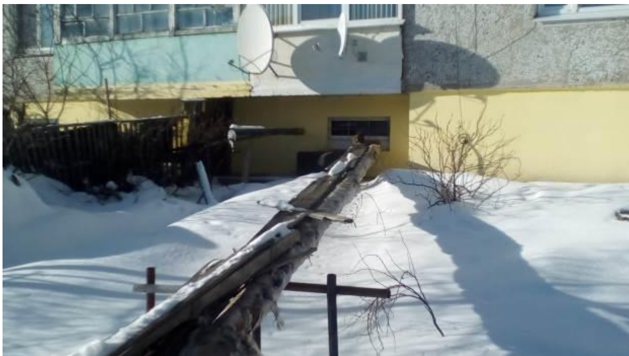
Рис. 3.19. Участок №17 тепловой сети котельной мкр-на ДФЗ
