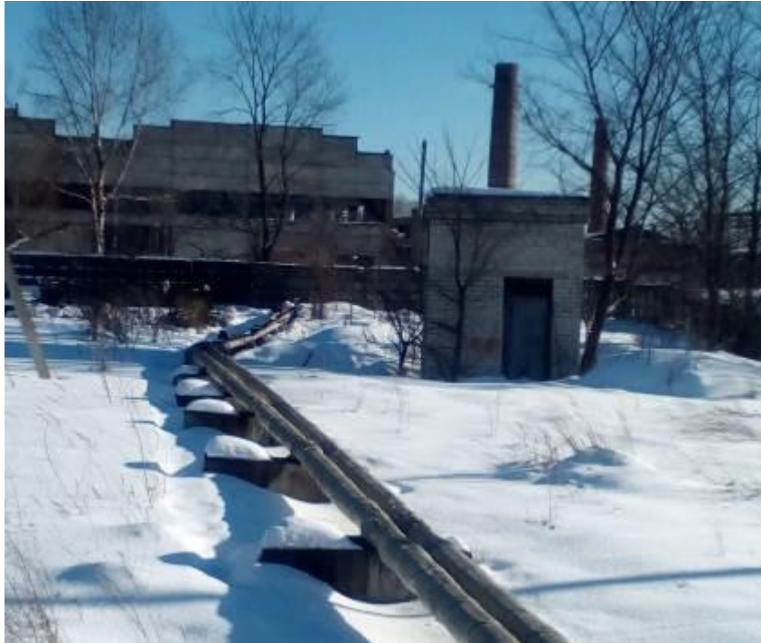
Рис. 3.11. Участок №5 тепловой сети котельной мкр-на ДФЗ
