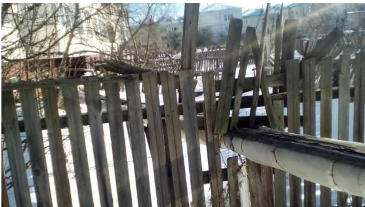
Рис. 3.20. Участок №19 тепловой сети котельной мкр-на ДФЗ
