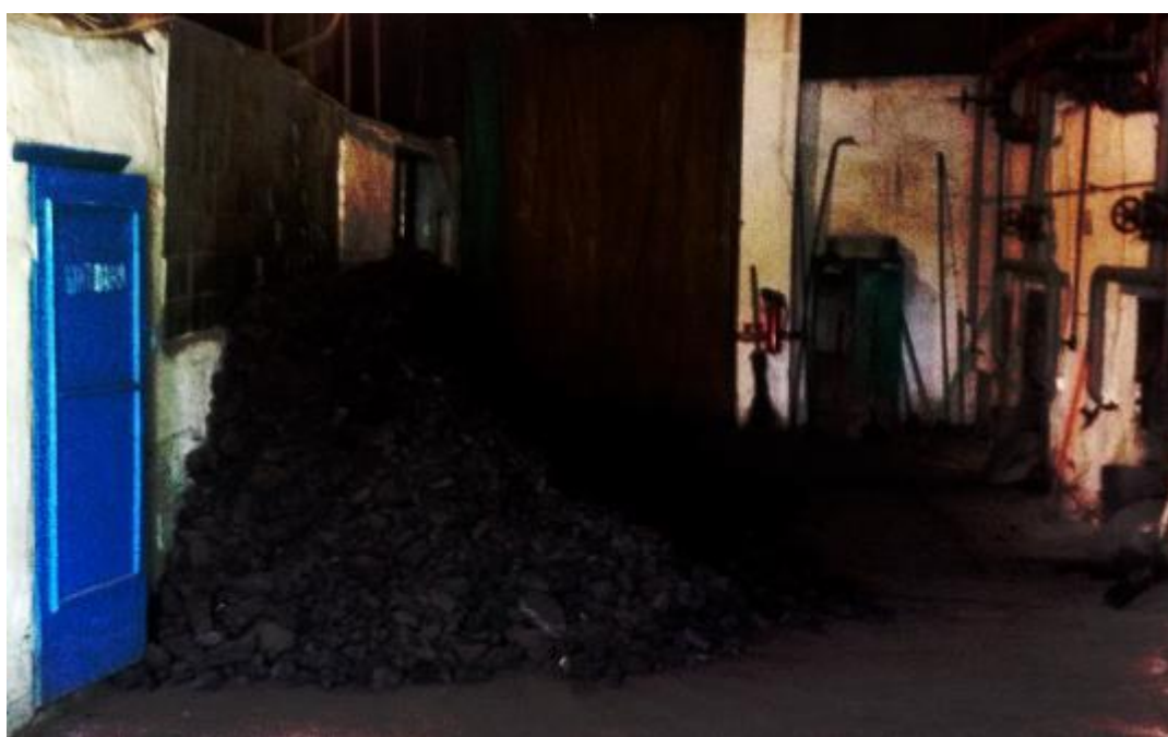
Рис. 3.27. Хранение топлива котельной ул. Десантная
