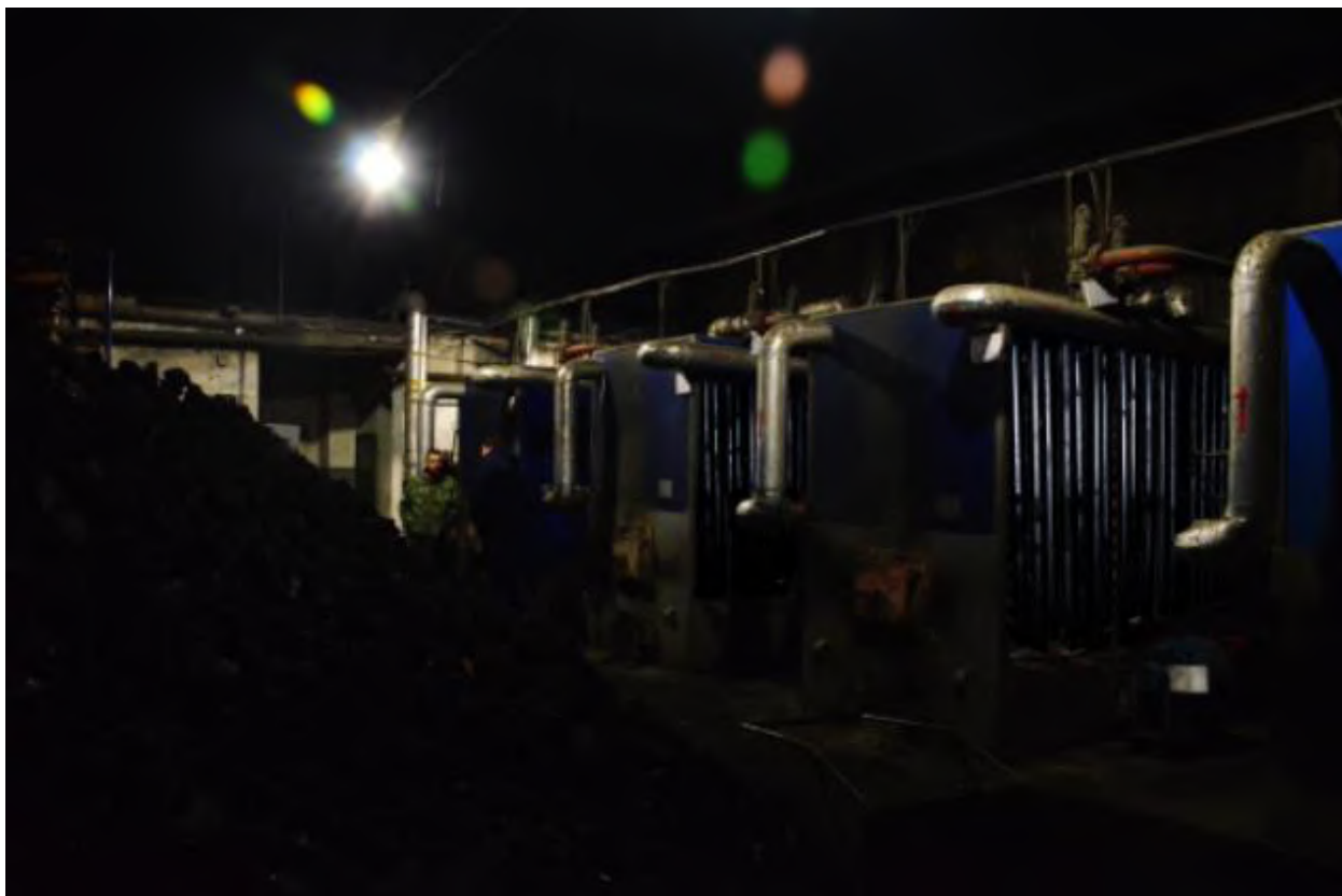
Рис. 3.7. Котельное оборудование в котельной мкр-на ДОЗ
