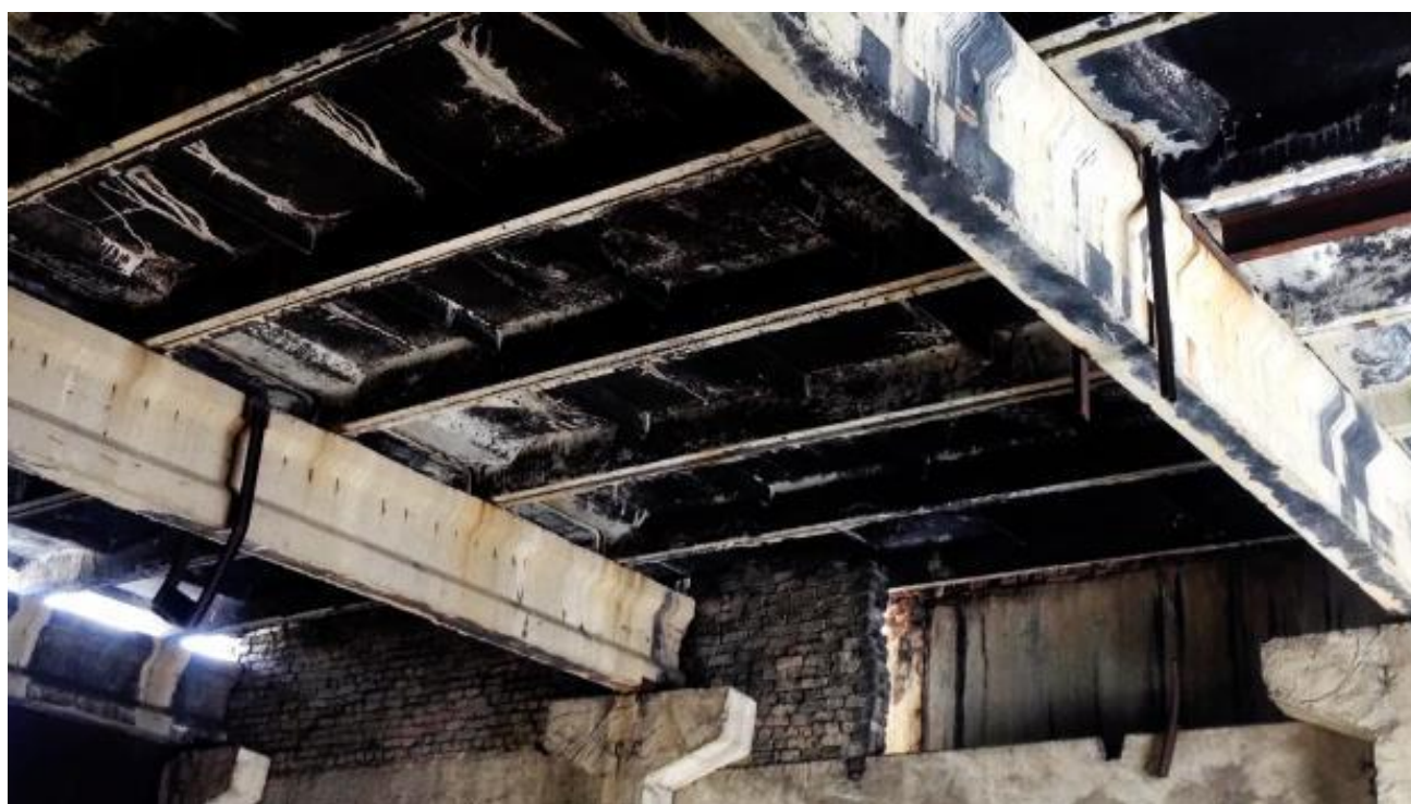
Рис. 3.22. Перекрытия котельной ул. Десантная
