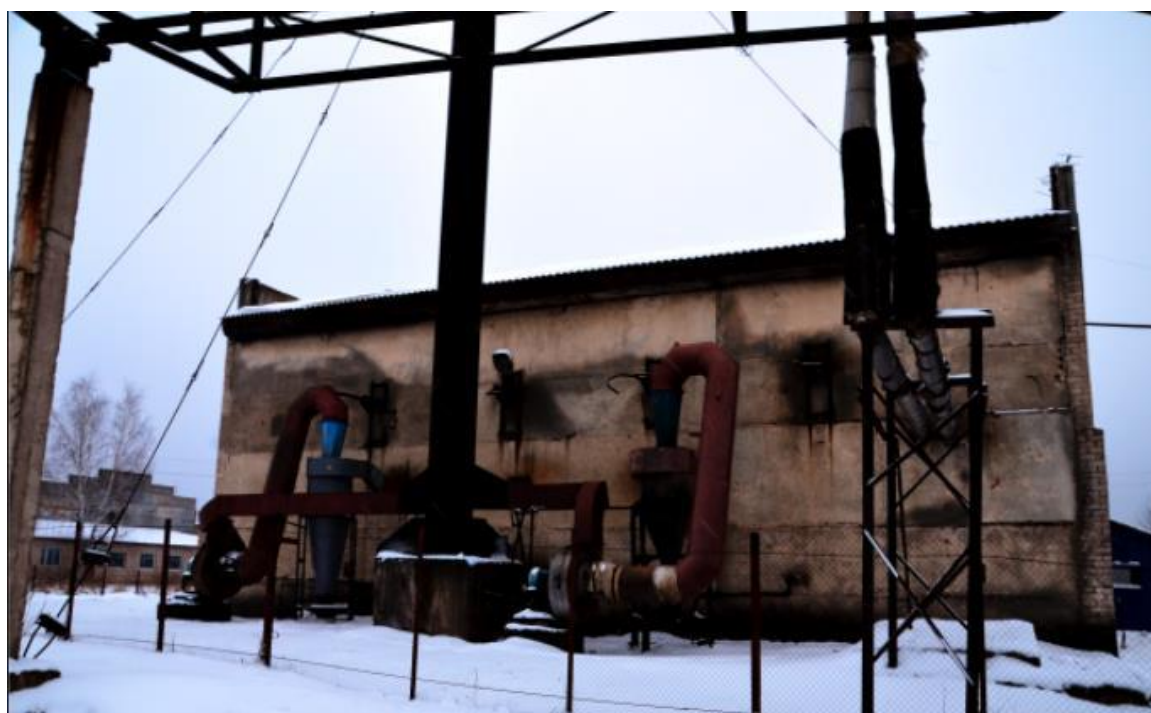
Рис. 3.2. Здание котельной мкр-на ДОЗ
