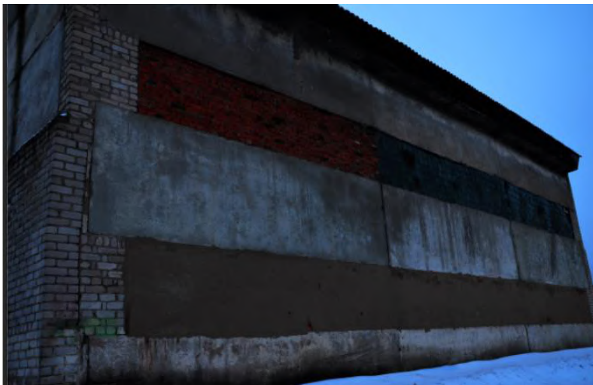
Рис. 3.3. Здание котельной мкр-на ДФЗ
