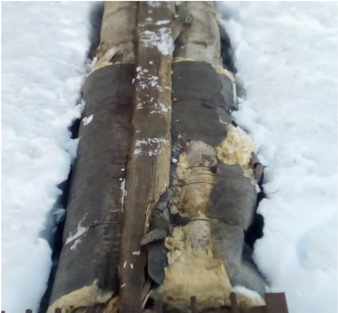
Рис. 3.12. Участок №7 тепловой сети котельной мкр-на ДФЗ
