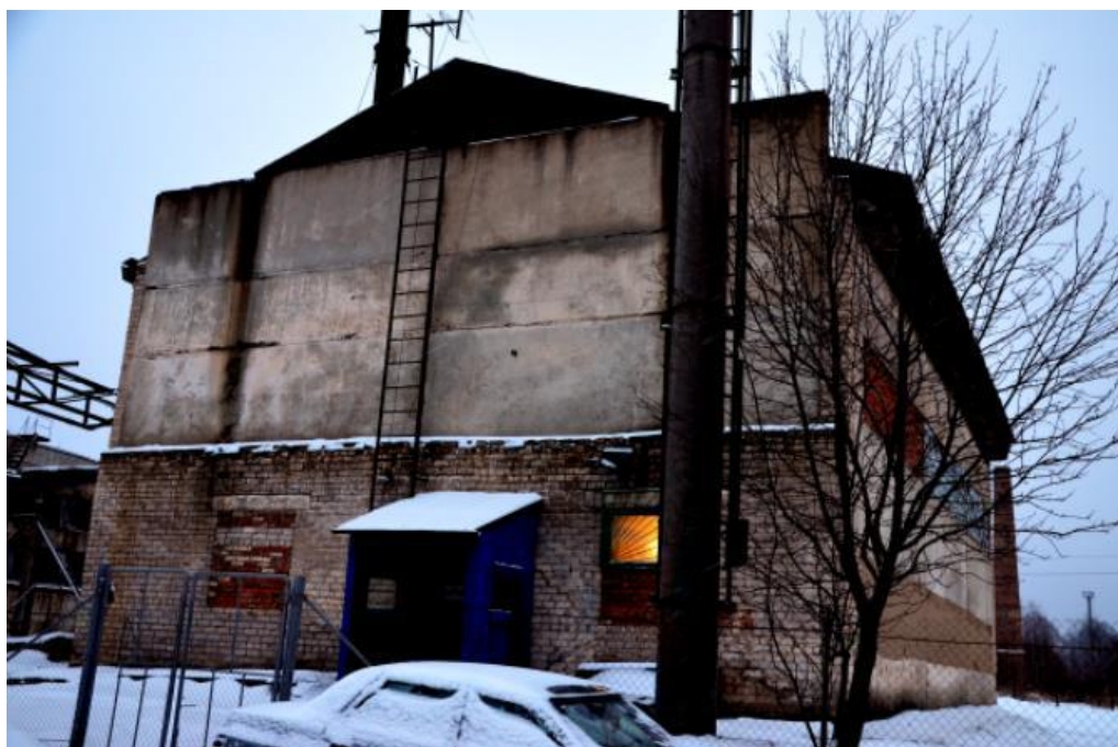
Рис. 3.1. Здание котельной мкр-на ДОЗ
