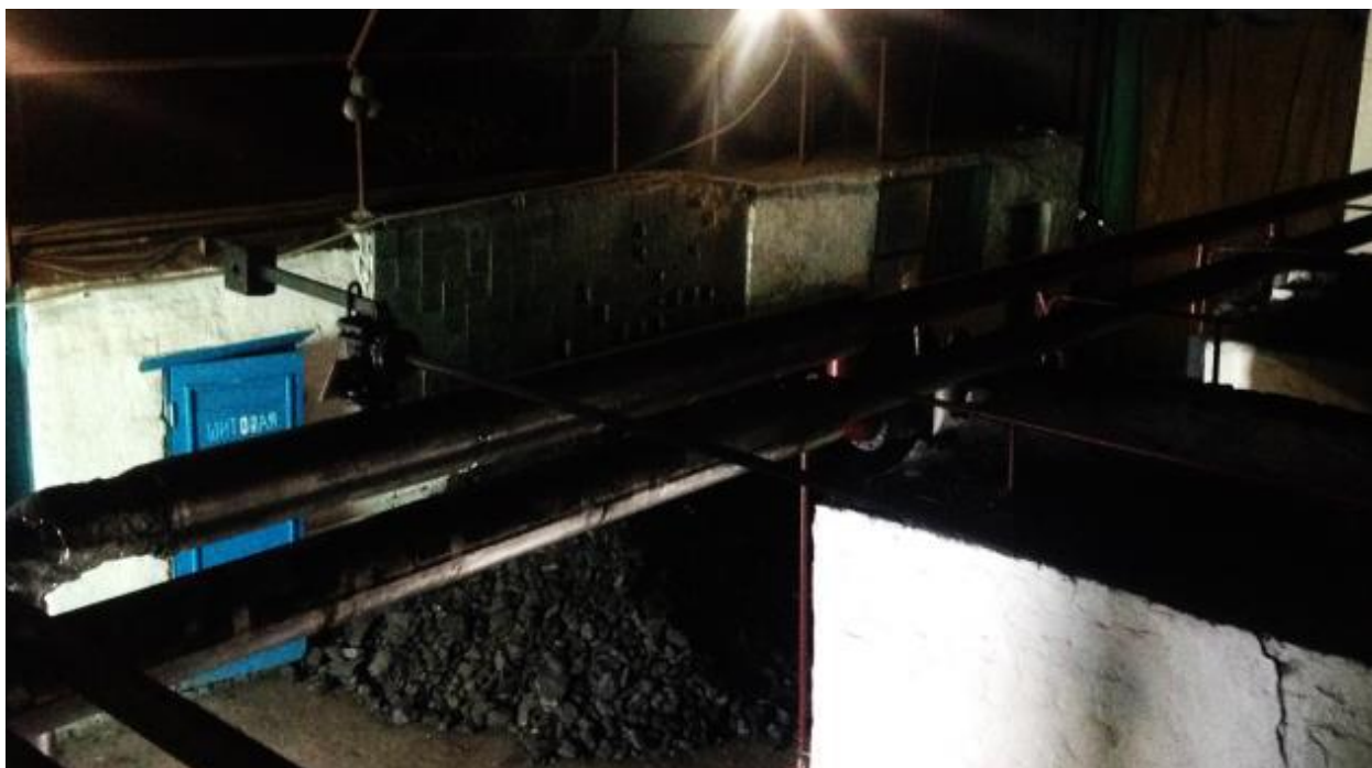
Рис. 3.23. Хранение топлива котельной ул. Десантная
