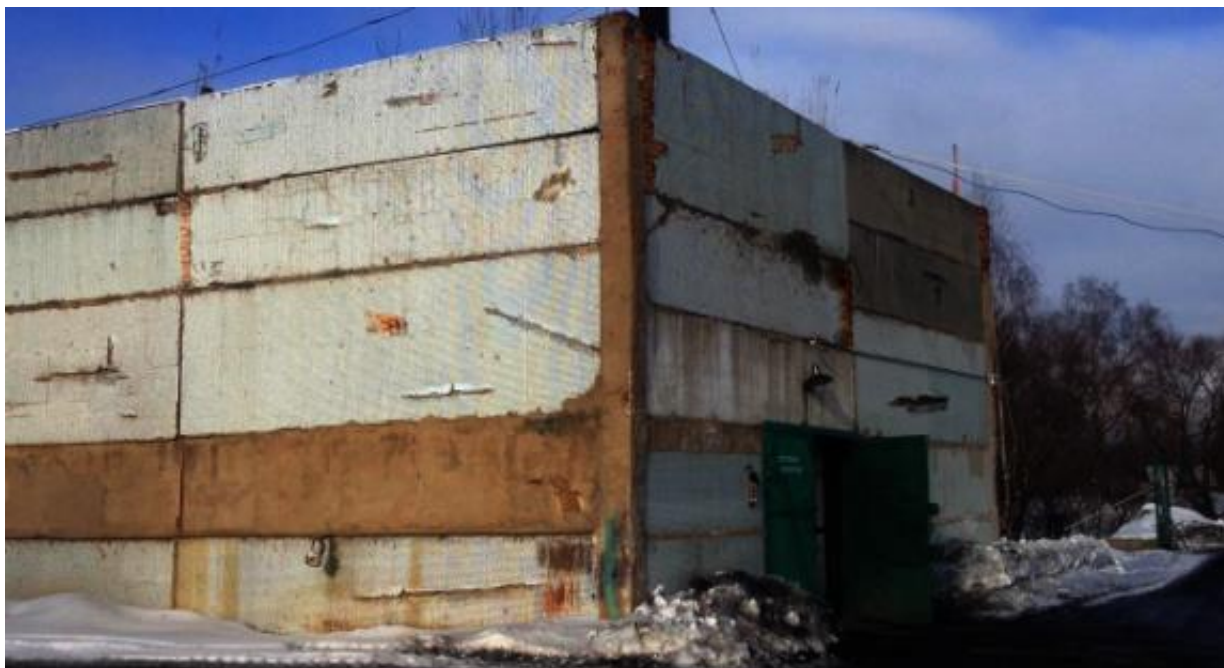
Рис. 3.21. Здание котельной ул. Десантная
