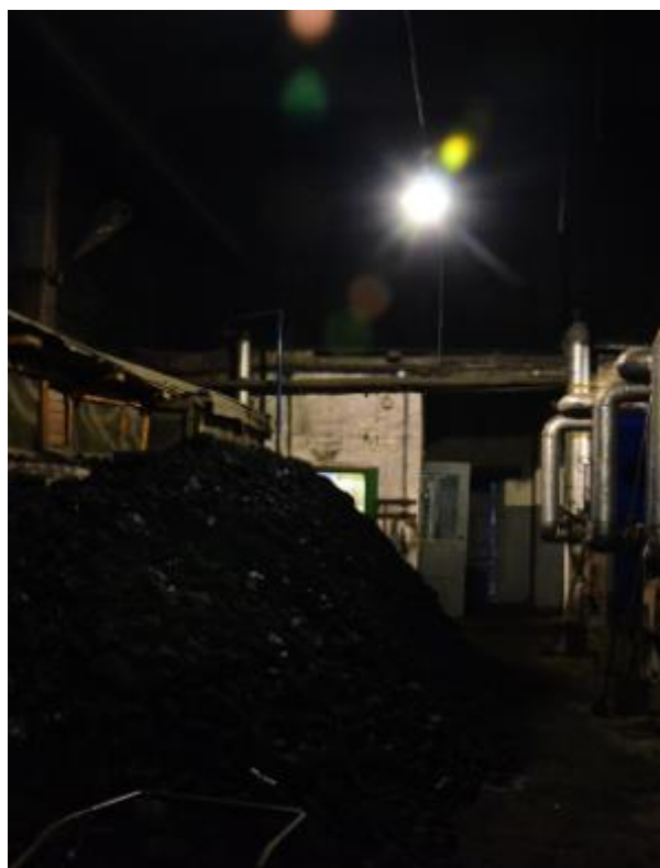
Рис. 3.8. Нарушение условий хранения топлива. Внутреннее состояние помещения котельной мкр-на ДОЗ
